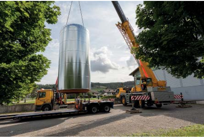
Der neue Wärmespeicher wird eingeliefert.
