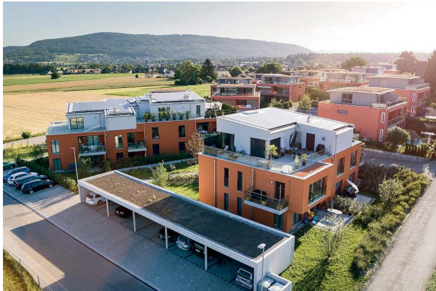
Solaranlage auf den Dächern der beiden Häuser.
