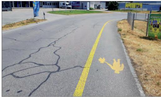
nierungsaufwand zu rechnen. Würde, wie zuerst beabsichtigt, lediglich der Deckbelag ersetzt, würde es sich um eine kosmetische und kurzfristige Massnahme handeln, und erneute Schäden wären zu erwarten. Immerhin kann auf den Einbau einer noch teureren Betonplatte verzichtet werden. Wie die durchgeführten Sondierungen ergeben haben, sei die Fundationsschicht, respektive deren Tragfähigkeit, für den Neu-
