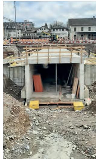
Die vorgefertigte Personenunterführung steht auf der Westseite des Bahnhofs Buchsi bereit für den Einschub unter die Gleise. (Bild: hwh)
