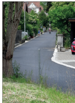
Blumenweg: Der Deckbelag wurde eingebaut.
