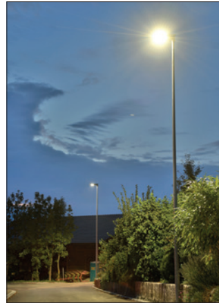
Noch in diesem Jahr soll die gesamte Strassenbeleuchtung in Herzogenbuchsee auf LED-Leuchten umgerüstet sein (Bild: Finstergasse); bis 2028 sollen dann auch alle Leuchtmittel in sämtlichen Gemeindegebäuden folgen.
