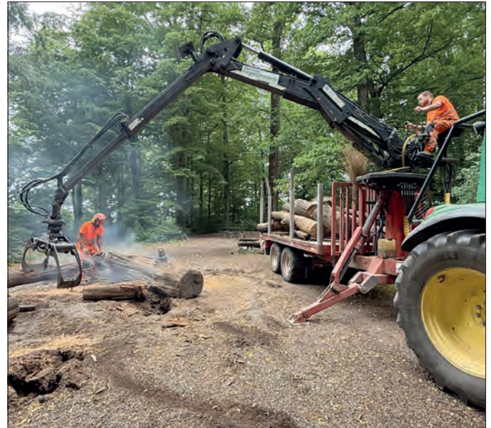
Das Forstteam der Burgergemeinde Herzogenbuchsee bei der Arbeit: In der ersten Juli-Hälfte wurde das alte Spielgerät demontiert und der Spielplatz neu aufgebaut.
